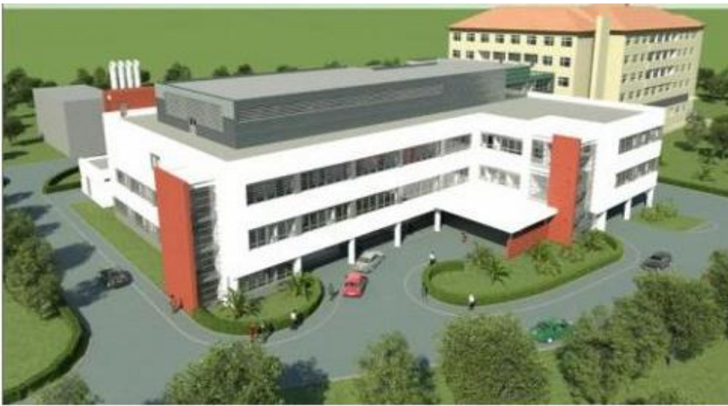
Slika 8: Dogradnja zgrade kirurgije Opće bolnice Varaždin
