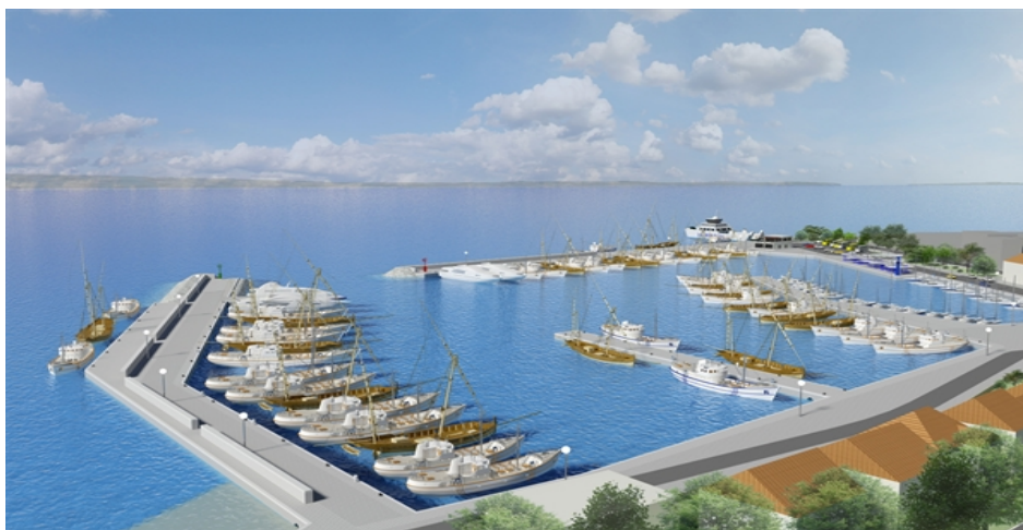
Slika 3.7. Izgled pomorske luke Krilo nakon završetka projekta
