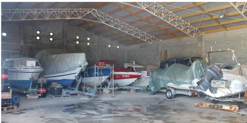
Slika 4: Prikaz unutarjosti suhe marine u kojoj se mogu vršiti popravci
