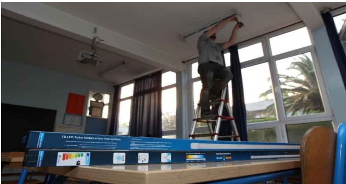
Slika 17 Postavljanje LED žarulja
