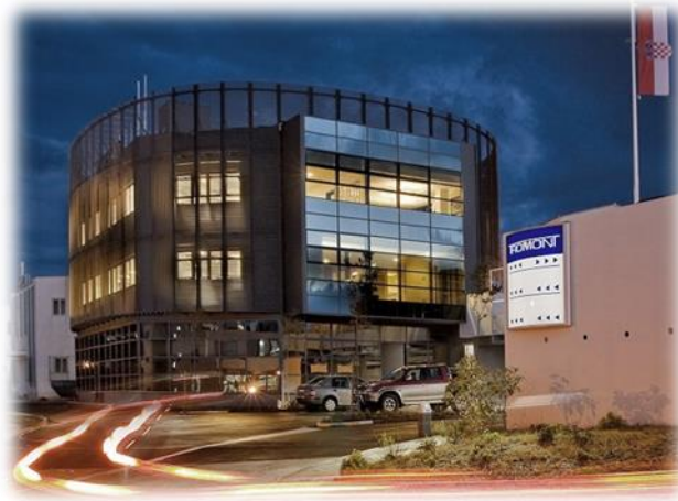
Slika 1:Upravna zgrada poduzeća Tromont. d.o.o. u Splitu
