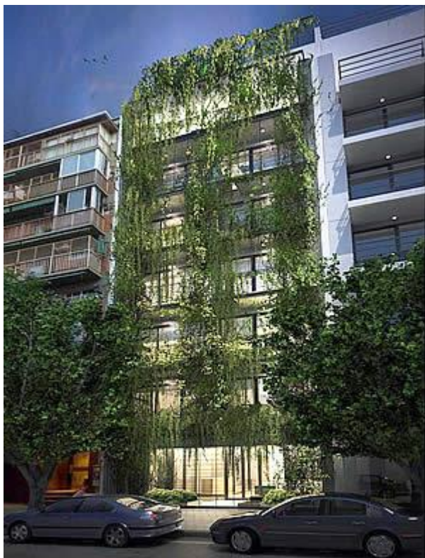
Slika 26. Vanjski izgled hotela Palo Santo
