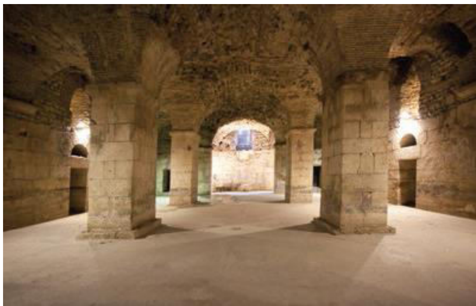
Slika 3. Velika trobrodna dvorana u zapadnom dijelu supstrukcija Dioklecijanove palače
