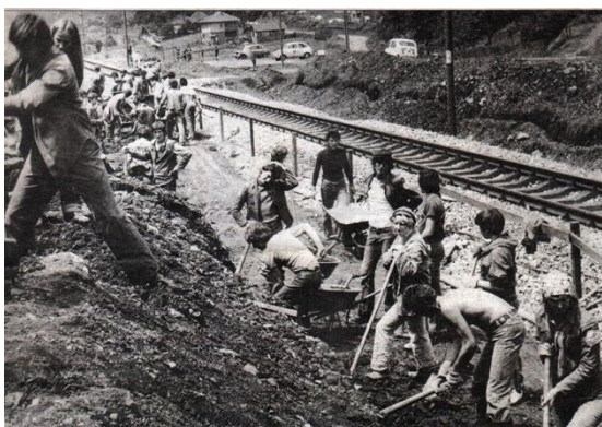
Slika 1. Radna akcija izgradnja pruge Sarajevo-Šamac (1)
