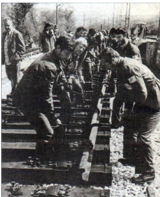
Slika 2. Radna akcija izgradnja pruge Sarajevo-Šamac (2)
