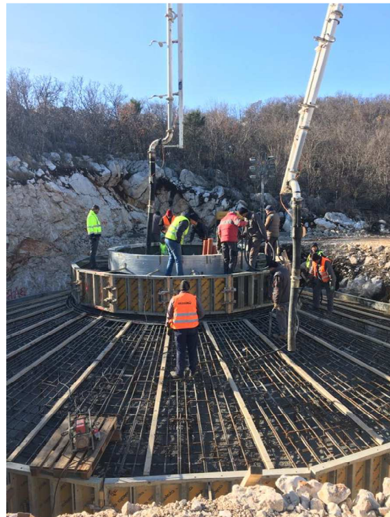
Slika 7. Izvođenje građevinskih radova na vjetroparku Izvor: facebook stranica Katić bau d.o.o.
