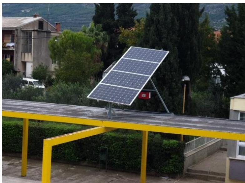
**Slika 7 Solarni suncokret**
