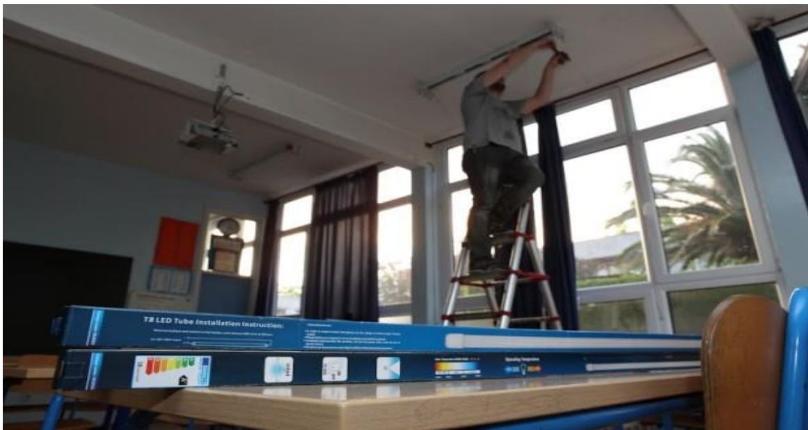
Slika 17 Postavljanje LED žarulja
