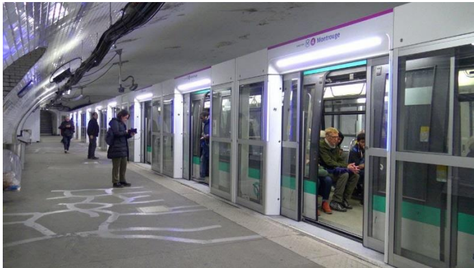
Slika 16: Automatizirana vrata koja odvajaju stanicu od tračnica
