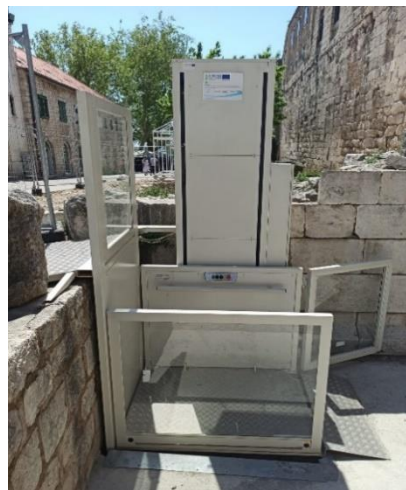
Slika broj 3: Vertikalno podizna platforma kod Srebrenih vrata Dioklecijanove palače
