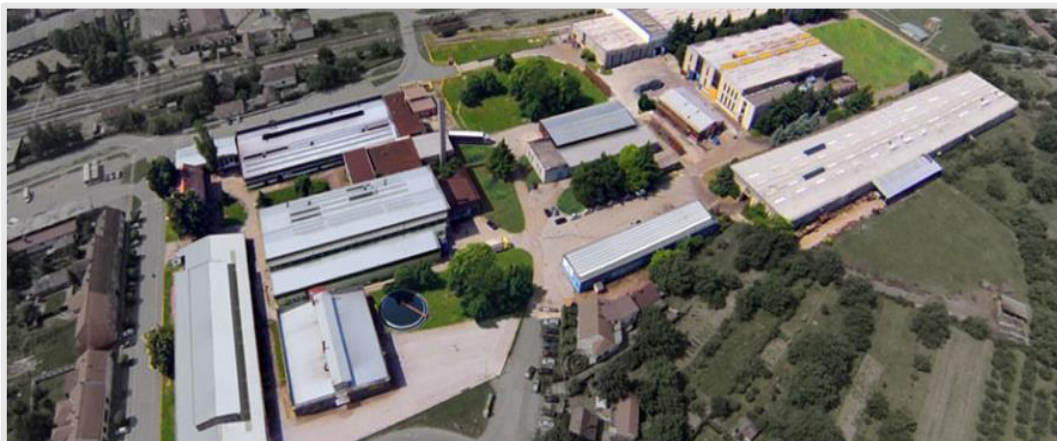
Slika 21: Kompleks i proizvodna postrojenja kompanije „Tang“
