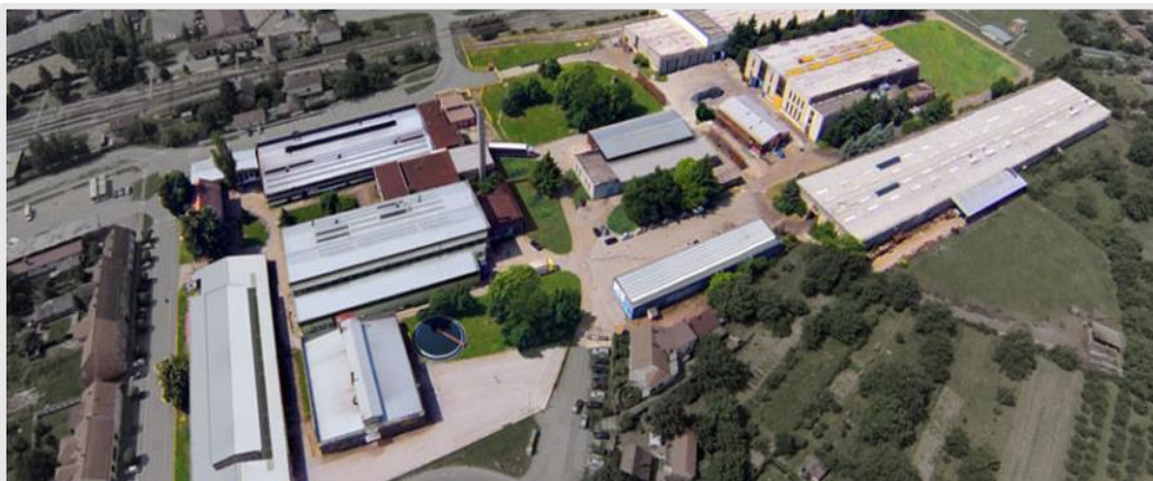
Slika 21: Kompleks i proizvodna postrojenja kompanije „Tang“
